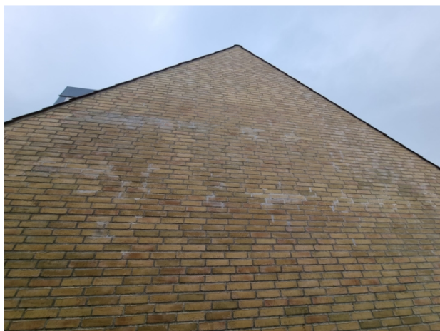
Facade med mindre udbedringer.
